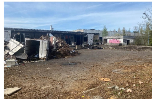
Photo 6 – Stockage et tri suite à un démantèlement des machines et autres matériels
